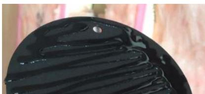
b) Rev-Loc の裏側全面に接着剤をイラストのように線の間が 6 mm 以上空かないようにびっしりとジグザグ状に塗ります。
