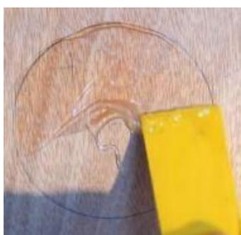
a) 接着箇所の埃をきれいにふきとり、乾燥した状態にします。表面のラフな部分を紙やすり等で削り、ラフな部分があるべくスムーズになるようにして下さい。Rev-Loc の裏面全体と接着箇所の表面の両方に接着剤を塗り、接着剤の層をつくるようにします。
