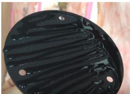
b) Rev-Loc の裏側全面に接着剤をイラストのように線の間が 6 mm 以上空かないようにびっしりとジグザグ状に塗ります。
